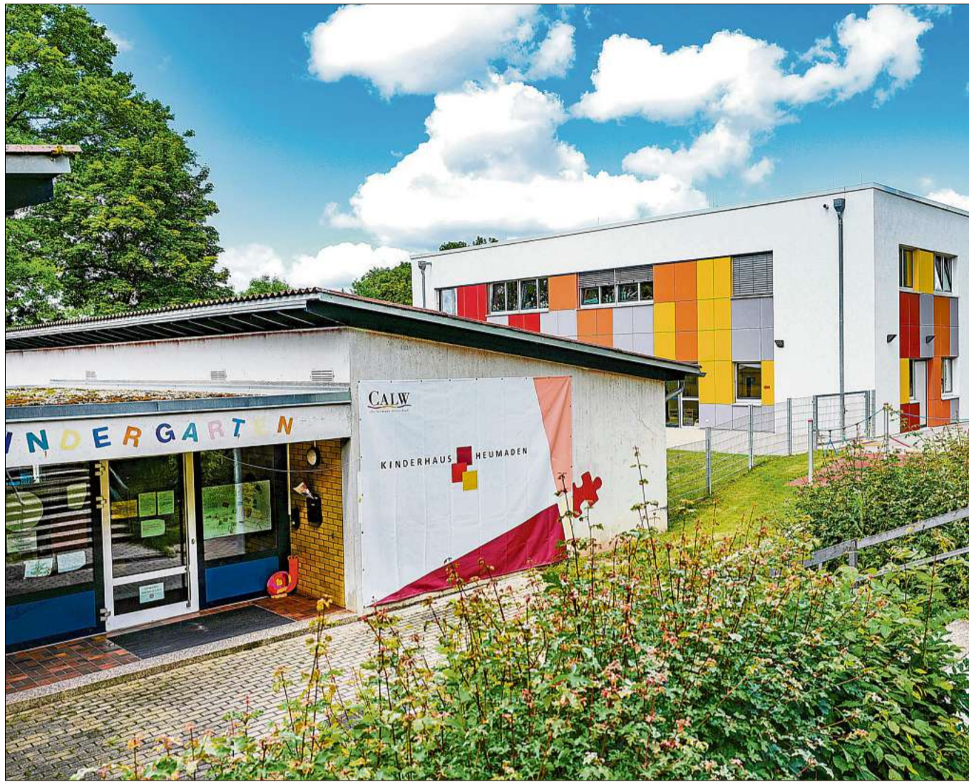
Der Kindergarten in der Breite Heerstraße in Heumaden wird saniert.
