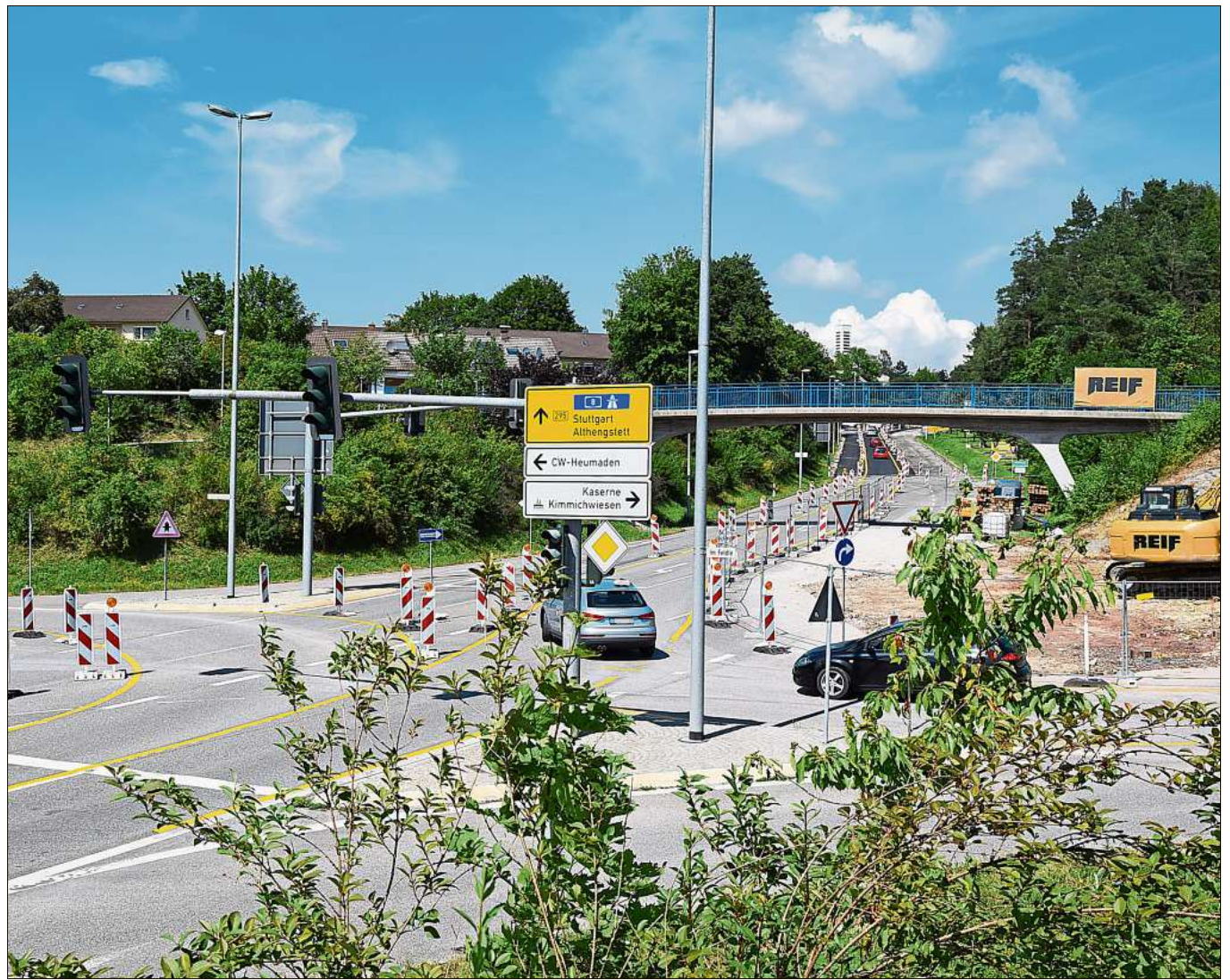
Der erste Bauabschnitt an der B 295 wird bald abgeschlossen. Am Ende wird die Straße zwei Tage lang voll gesperrt. Foto: Rousek
