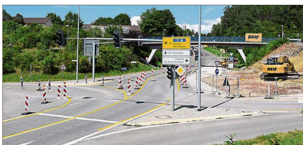
Die Baustelle an der B 295 sorgt für Einschränkungen.
