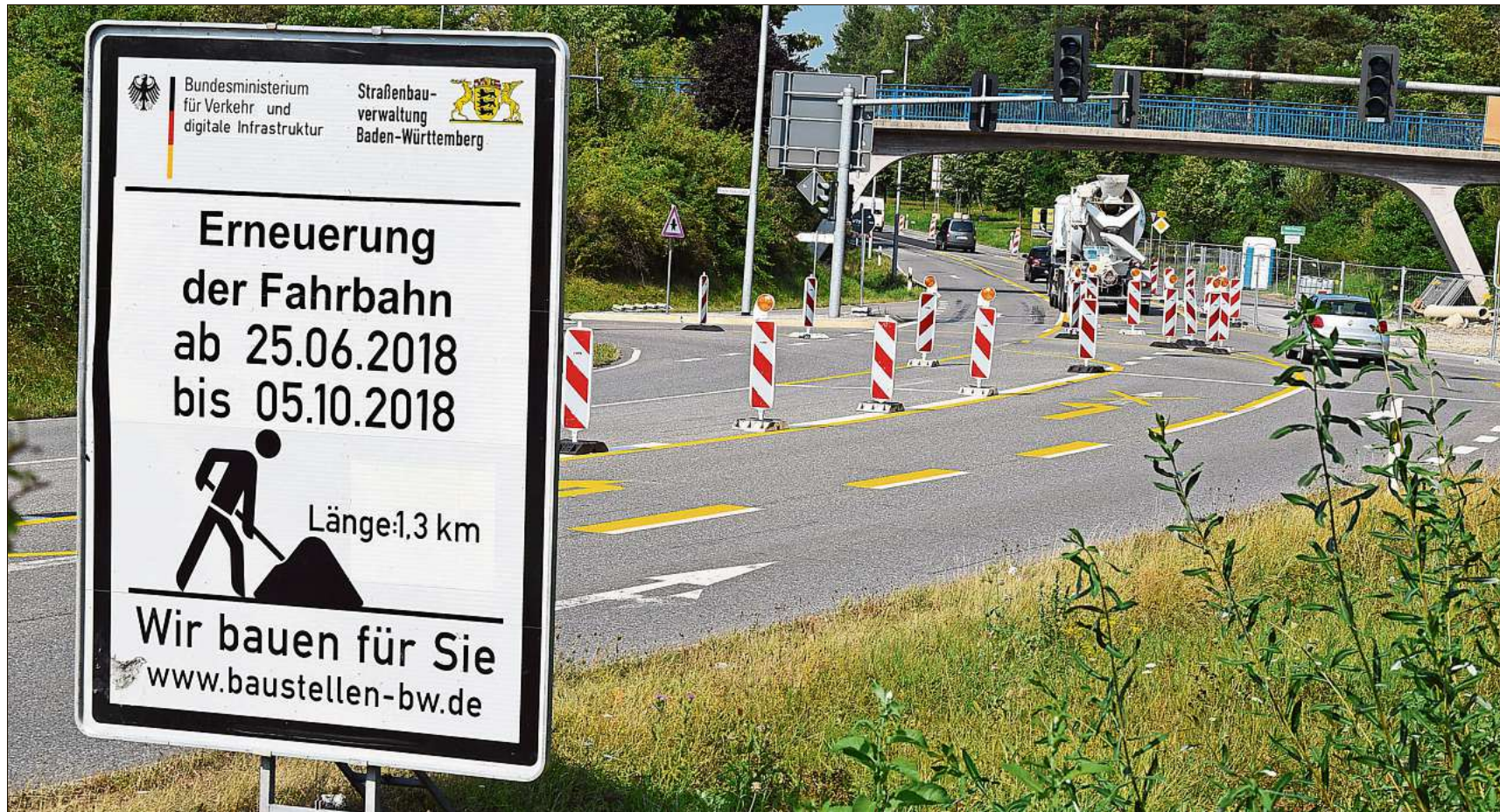
Anders als noch auf dem Baustellenschild angegeben, wird die Sanierung der B295 wohl bereits Anfang September fertig.
